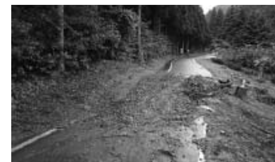
▲土砂崩れにより通行止めとなった県道金山新地停車場線（9月27日撮影）
