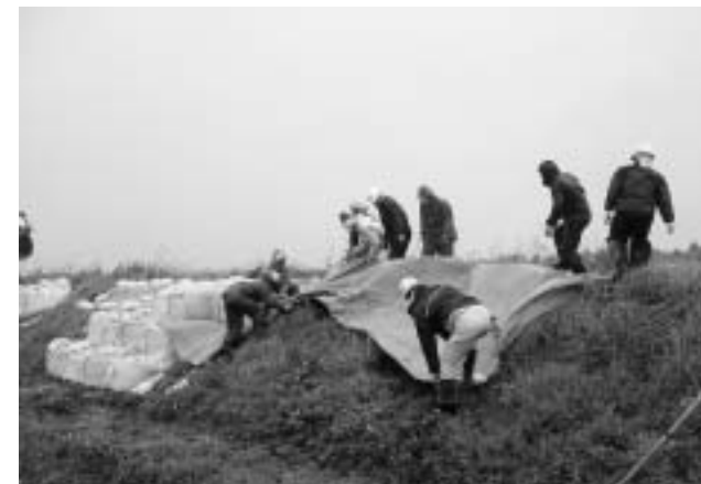
▲三滝川での水防作業（10月7日撮影）
