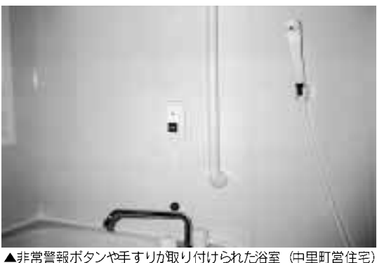
▲非常警報ボタンや手すり取り付けられた浴室（中里町営住宅）
