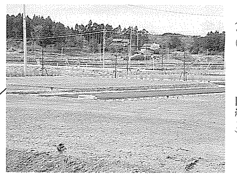
▲まもなく完成する中里住宅地
