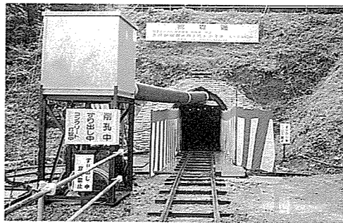
▲1号トンネル入口
