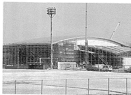
▲完成間近の総合体育館
