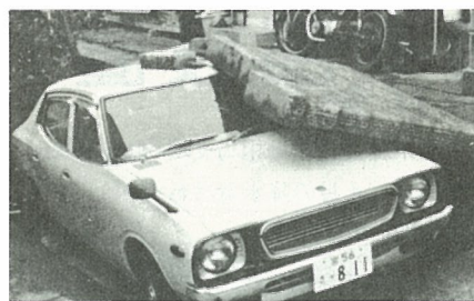
▲ブロック塀は道路側に倒れる (S53年 宮城県沖地震より)
