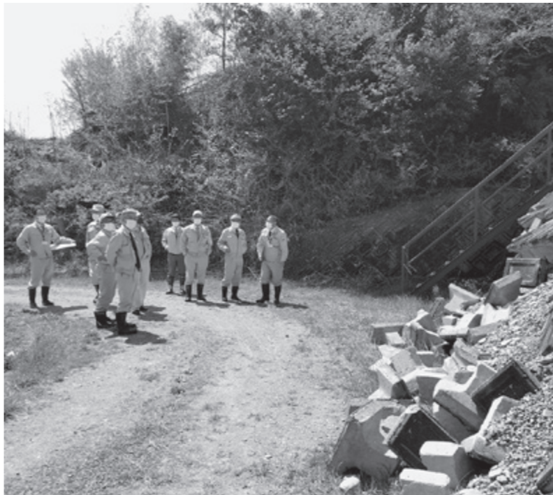
▲鴻ノ巣ダム被害状況を視察
