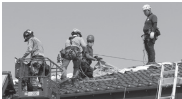
▲修復作業するボランティア団体
