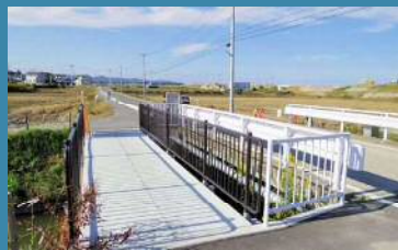
39.町道・田中大戸浜線歩道整備
