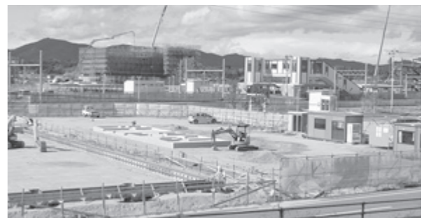
▲完成間近のフットサル場
