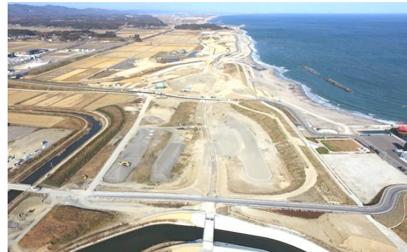
盛土が終わり施設整備が進む釣師防災緑地
