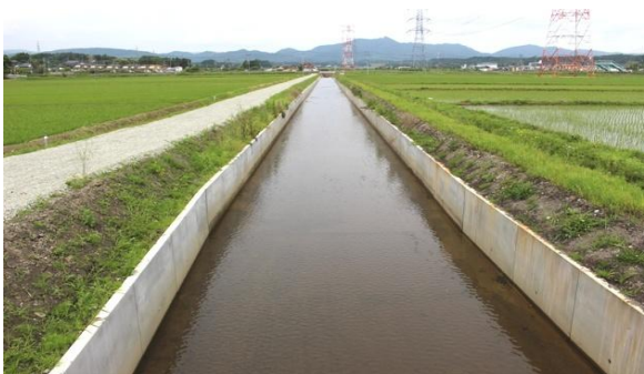
排水路が復旧した駒ヶ嶺駅東「江堀川」
