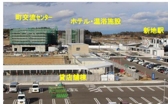
大規模な建築工事がすすむ新地駅前
