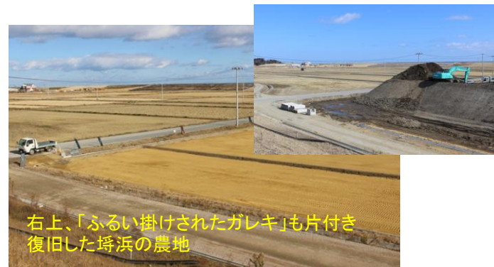
農地のガレキ撤去も完了(埴浜付近)
