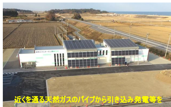
駅東に完成した「新地エネルギーセンター」
