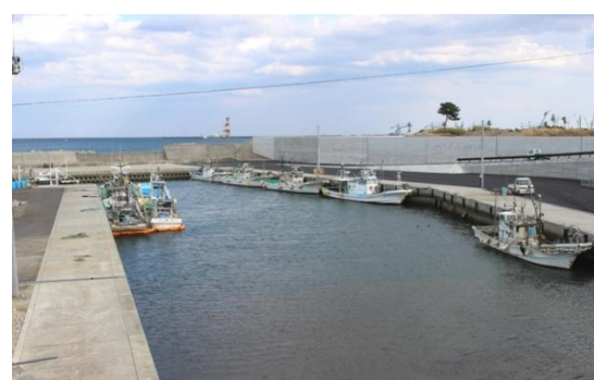
防潮堤：漁港南ドック端部
