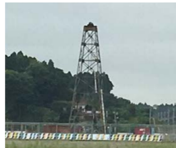
安全祈願祭（H30.7.11） 温泉掘削の様子：地下326mまで掘り、湧き出た28.1℃の源泉を揚水ポンプで汲み上げます。
