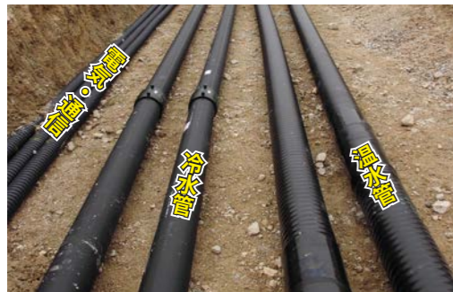
深さ約1.3m、幅約2.6mの中に合計7本の管が埋設され、地区内を巡っています。
