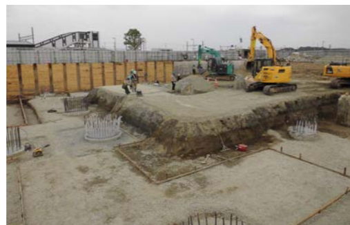
最も深いところで約3m掘削し、基礎を構築します。写真中、丸く見えるのが基礎杭の頭部で、建物を支える重要な役割をはたします。
