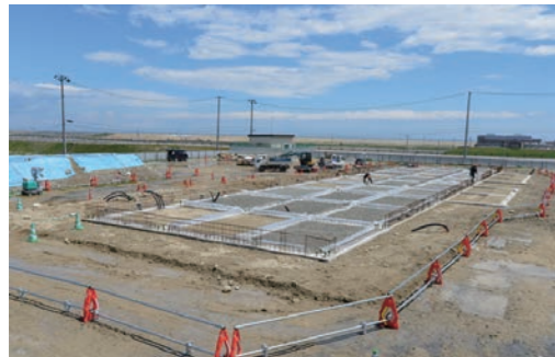
基礎工事及び埋め戻し工事が完了
