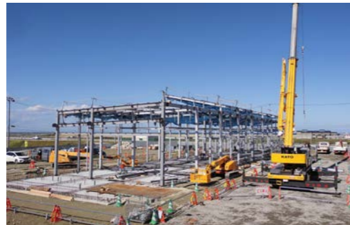
鉄骨建て方工事の様子
