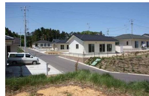
作田西町営住宅(9戸)
