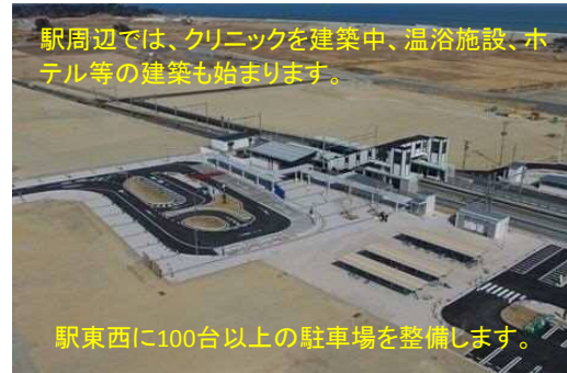
駅周辺では、クリニックを建築中、温浴施設、ホテル等の建築も始まります。 駅東西に100台以上の駐車場を整備します。
