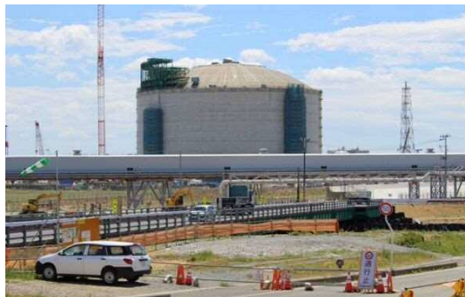
相馬港(町内)に建設中のLNG基地
