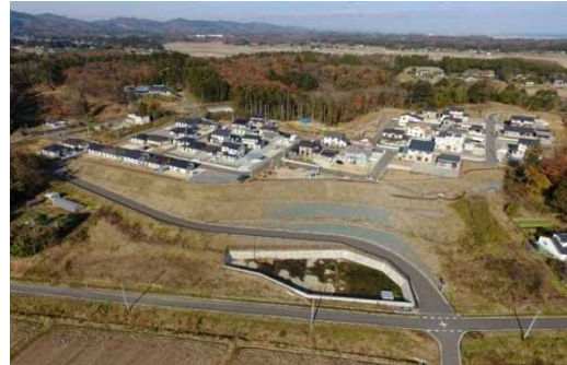
作田西団地（防集28区画、町営住宅9戸）
