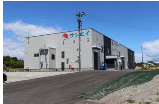
完成した水産加工施設（大戸浜地内）
