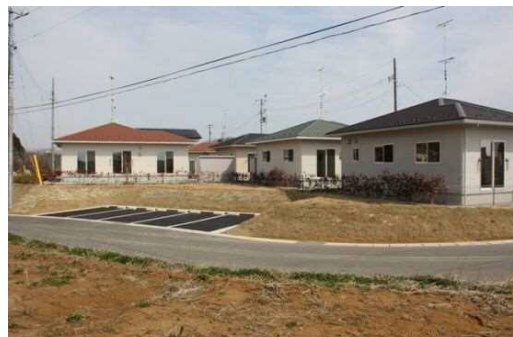
作田東町営住宅(6戸)
