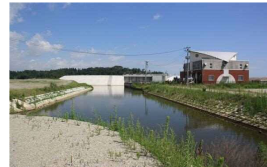
排水機場も復旧完了（写真は埼玉）
