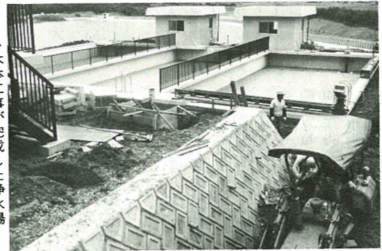
本体工事が完成した浄水場
