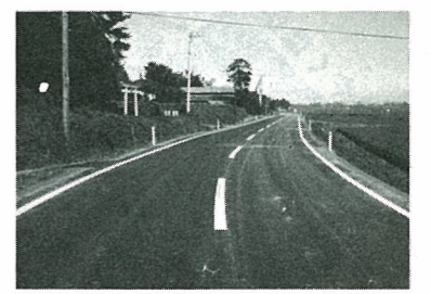
▲舗装が完了した中里磯山線 (木崎地内)
