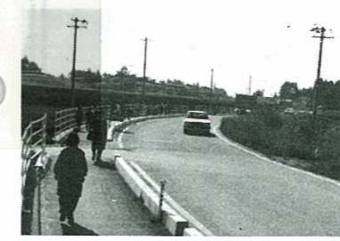
▲菅谷今神線歩道工事 (藤崎地内 9/26まで)
