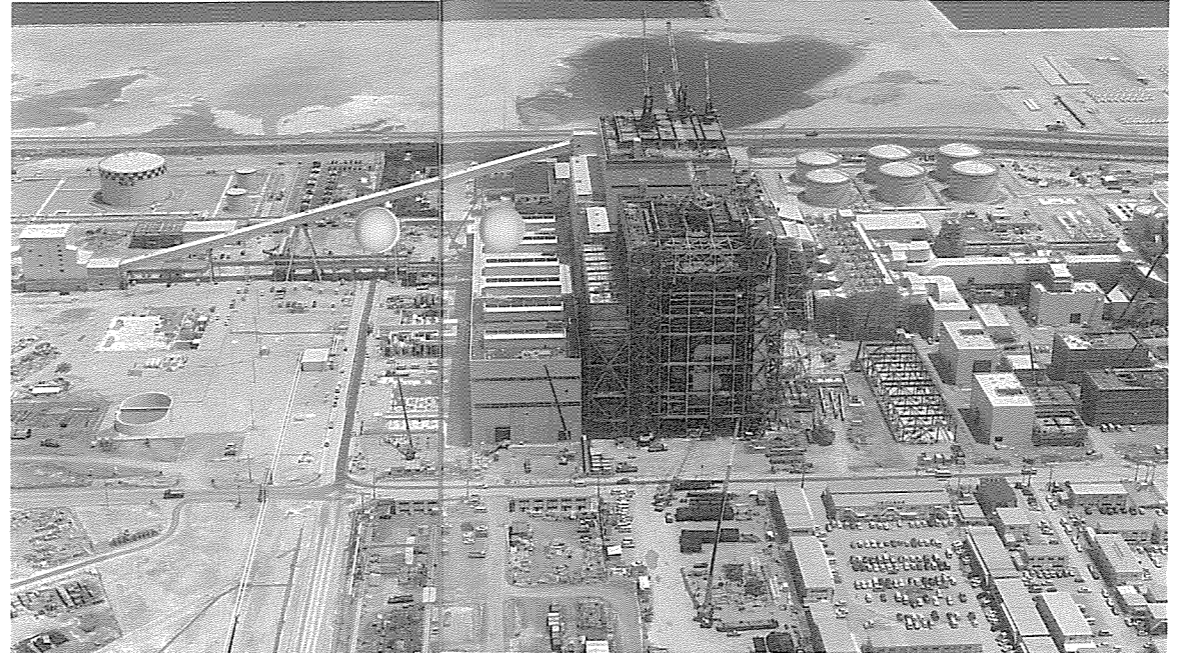
▲地域の熱い期待を担い、工事が急ピッチで進む火力発電所
