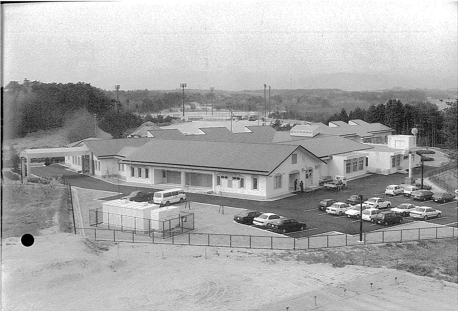
▲ 特別養護老人ホーム「新地ホーム」全景
