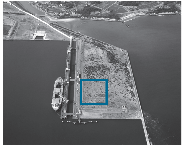
相馬港5号ふ頭内の再建予定地
