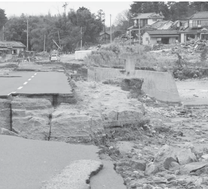
津波被害を受けた主要地方道相馬・巨理線
